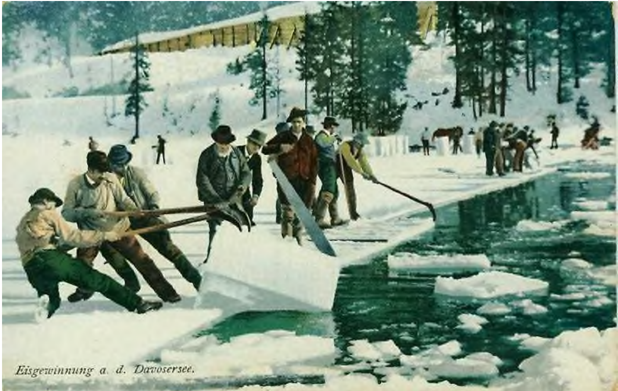
Die Eisernernte im See, im Hintergrund werden die Blöcke für den Pferdetransport vorbereitet und auf dem Hügel die Holzwand mit den eingelagerten Eisblöcken
